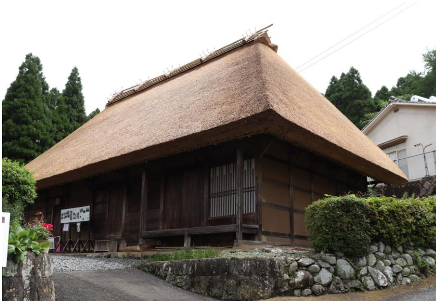
▲国指定有形文化財後藤家住宅保存修理状況
