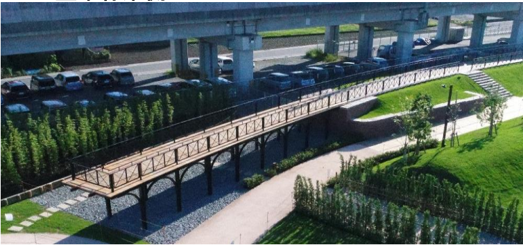
▲整備完了写真
