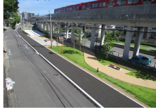
▲整備完了写真
