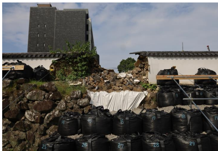
▲県指定史跡府内城跡土堀災害状況
