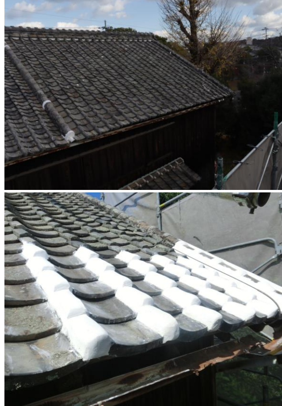
▲県指定史跡毛利空桑塾跡災害復旧工事状況
