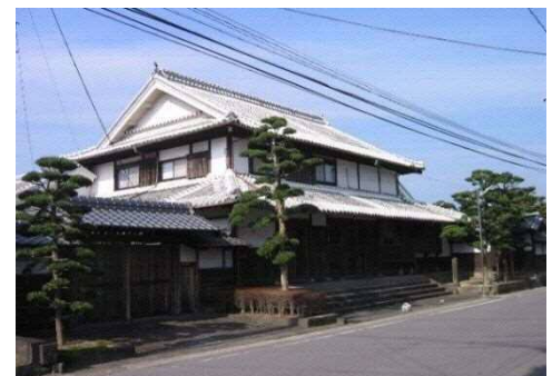
帆足家分家住宅「松石不老館」（主屋）
