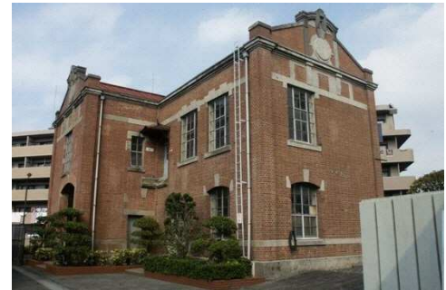
九州電力上野変電所
