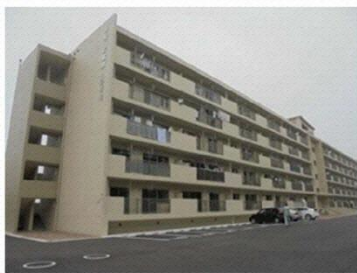
津波避難ビルに指定
