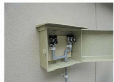
炊き出し用ガス配管
