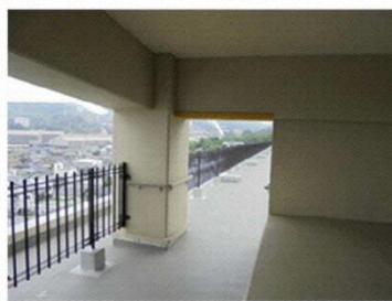
屋上避難スペース
