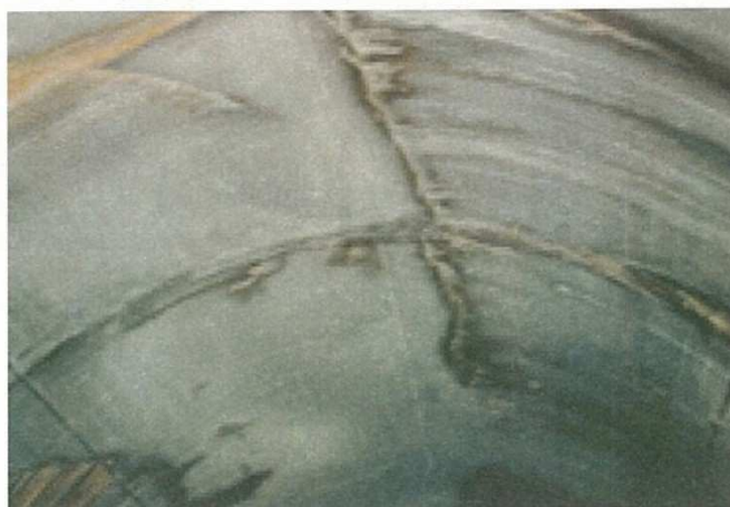
写真-解 7.3 覆工の天端付近に発生した縦断方向のひび割れの例
