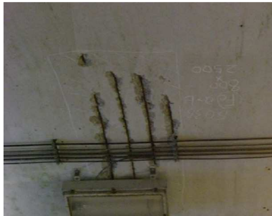
写真-解 8.2 鋼材腐食の例
