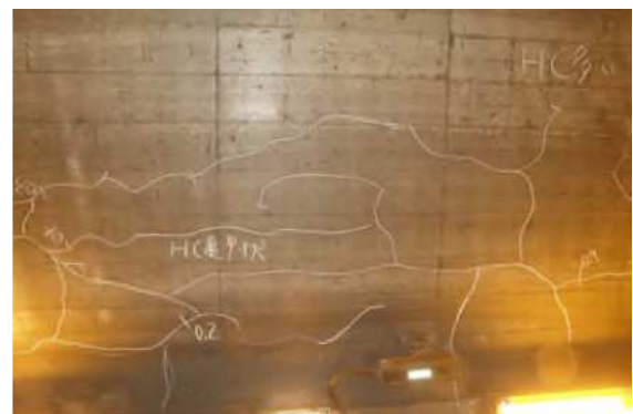
写真-解 7.5 複数のひび割れで覆工コンクリートがブロック化している例
