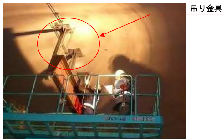
写真-解 6.3 触診作業状況
