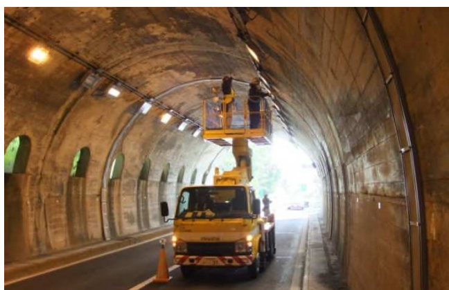
写真-解 6.1 近接目視作業状況
