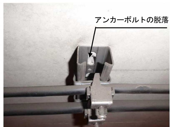
写真-解 7.12 固定金具の腐食とアンカーボルトの脱落の例
