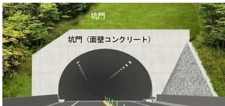
図-7.2 点検対象箇所（トンネル坑口部）
