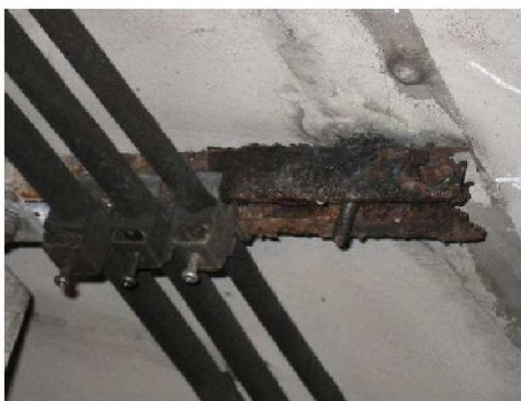
写真-解 7.12 固定金具の腐食とアンカーボルトの脱落の例
