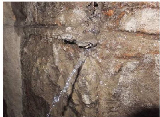
写真-解 7.7 漏水(噴出)している例
