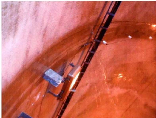
写真-解 7.7 漏水(噴出)している例
