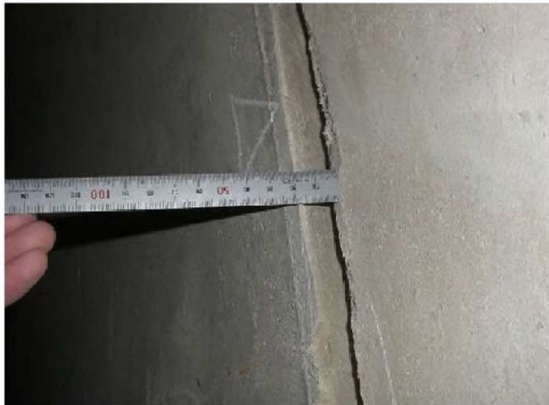
写真-解 7.8 段差の例
