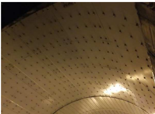
写真-解 7.10 鋼板接着 (左)・繊維シートの接着 (右) 例
