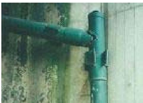
プラスチックが劣化により破損している
