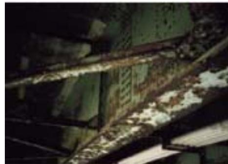
主部材の広範囲で著しい腐食により断面減少が生じている
