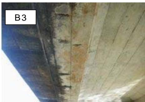
主たる構造部材で、鉄筋露出が散見されるが、鉄筋の腐食は軽微である
