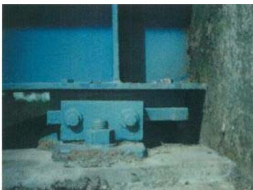
可動支承においてストッパーへの衝突が生じており、可動機能が損なわれている
