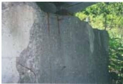
凍害の恐れのある断面欠損
