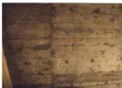
漏水・遊離石灰が殆ど生じていない0.2mm以上を主とした2方向ひびわれ
