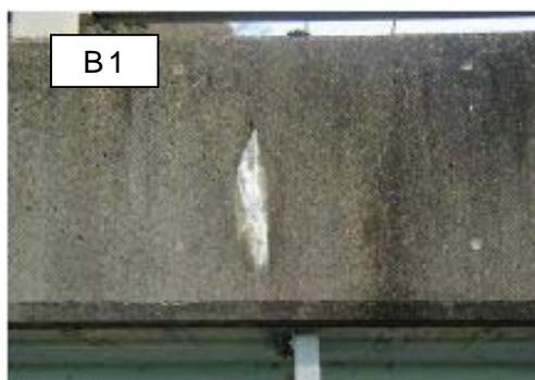
二次部材に局所的な漏水・遊離石灰が確認される。
