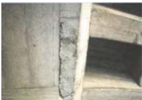
桁下が鉄道・道路など第三者被害の恐れがある箇所とうきが生じている
