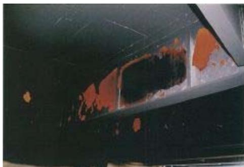
火災によって桁の構造性能
