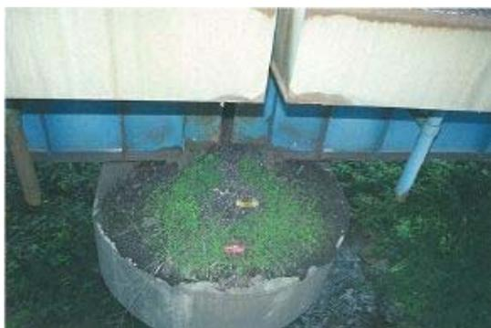
支承に大量の土砂が堆積し、支承の可動性能が損なわれている
