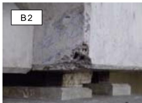
主たる構造部材で、局部的に鉄筋が露出しているが、鉄筋の腐食は軽微である
