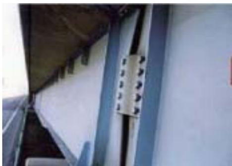
鋼主桁に変形が生じている
