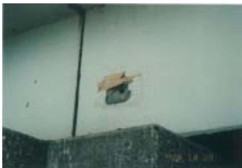
横締めが破断し抜け出している
