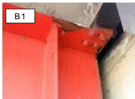
局部的に生じた表面錆程度の腐食や塗装劣化
