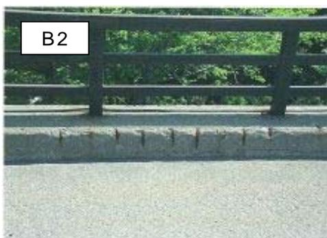
地覆等の二次部材において剥離・鉄筋露出が散見される
