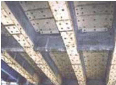
補強鋼板の腐食が広範囲で生じている
