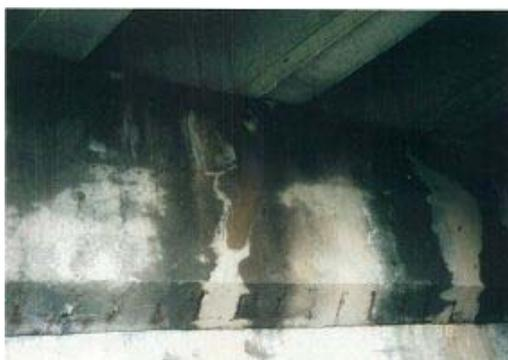
コンクリート橋において伸縮装置の防水機能低下による漏水が見られる
