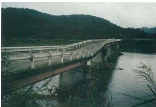
橋脚に沈下が生じている
