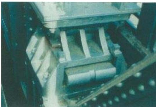
ロッカー支承のロッカー部分が転倒している
