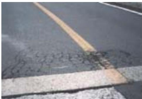
密な2方向ひびわれに加え、部分的に路面陥没が確認される
