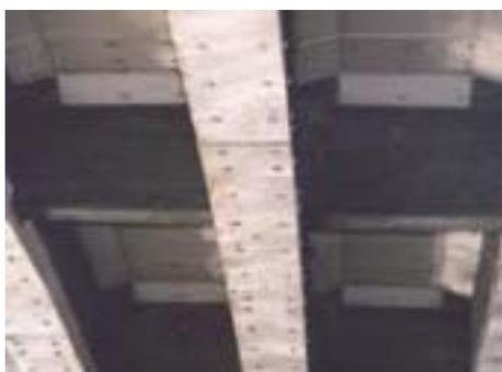
補強鋼板に局所的な表面錆が生じている
