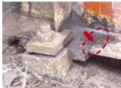
主桁下フランジのソールプレート前面に生じた亀裂又は塗膜割れ
