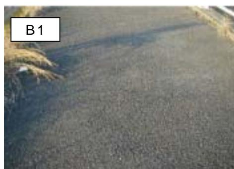
1方向の舗装ひびわれが局部的に確認される
