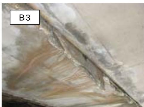
漏水により他部材の損傷進行を早める恐れのある目地材のずれ・脱落
