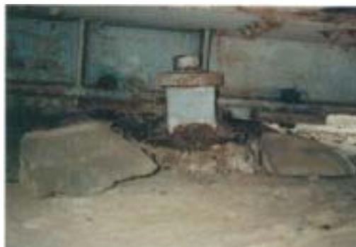
沓座モルタルが著しく欠損し、支承本体に傾斜又は沈下が生じている
