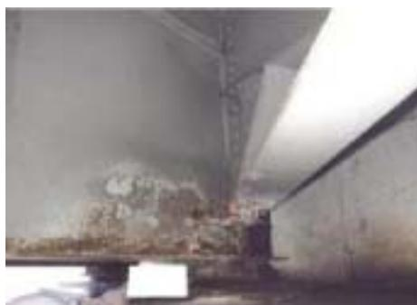
局部的であるが水の進入等により進行が速い位置で確認される主部材の断面減少に至る腐食
