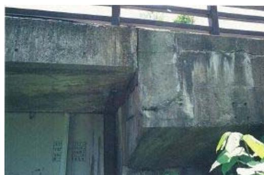
桁と胸壁が接触しており、下部工の移動の疑いがある
