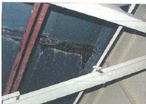
鋼板の断面減少が生じている
