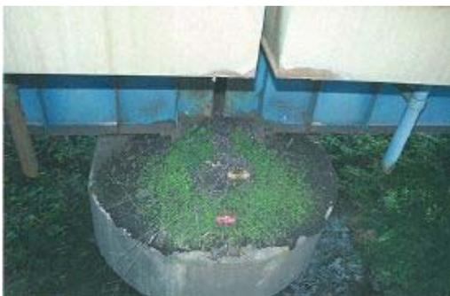
沓座に土砂が堆積している
