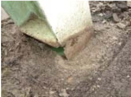
トラス材の著しい腐食により断面減少が生じている
