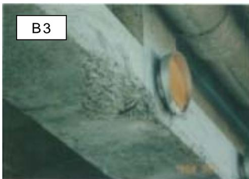
車両衝突により生じた軽微な断
