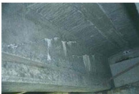
PC 鋼材の方向に沿ったひびわれからゲルが生じている
