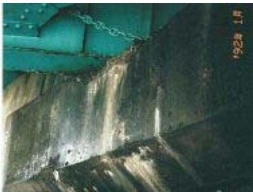
伸縮装置の防水機能低下により鋼桁等の腐食に繋がる著しい漏水が見られる
