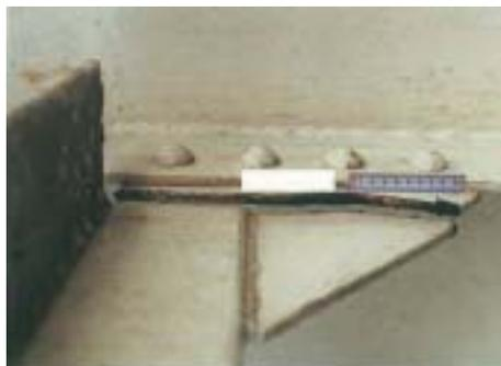
対傾構の破断
