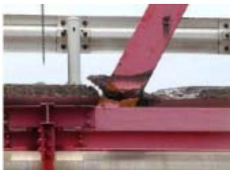
トラス橋の斜材の破断
