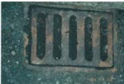
排水ますに土砂詰りが生じている
