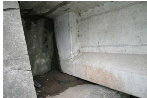
橋座の土砂堆積
