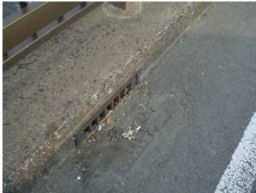
排水ますの土砂詰り
