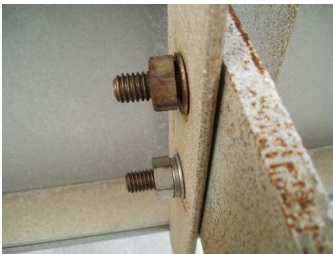
写真-解 8-10 設置後 10 年以内の附属物の変状事例
