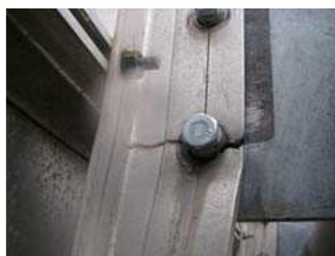
取付部の変状状況
