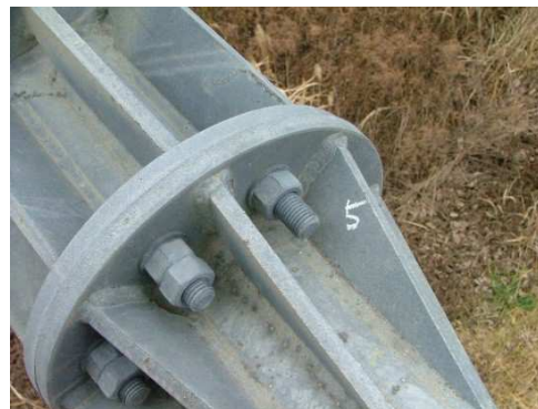
写真-解 8-10 設置後 10 年以内の附属物の変状事例
