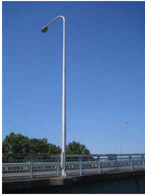
橋梁部に設置
