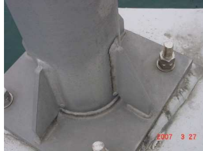
標識柱基部溶接部のき裂
