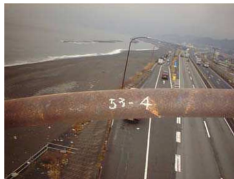
写真-解 8-11 支柱本体の腐食事例
