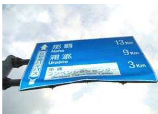
道路標識板の変状状況
