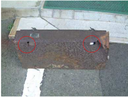
落下照明背面状況
