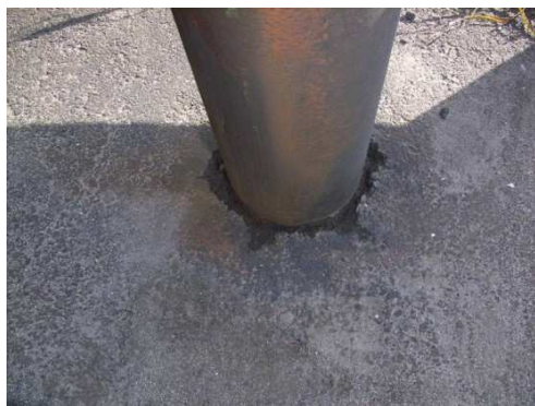
腐食、路面付近での滞水
