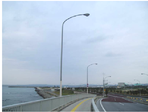
海岸付近に設置
