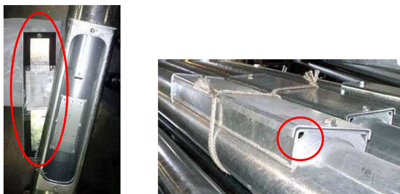
写真-2. 2 電気設備用開口部のパッキンと水抜き穴
