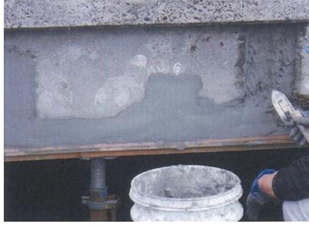
補修状況(断面修復工)
