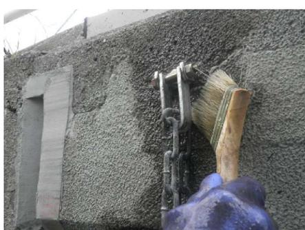
補修状況(表面含浸工)
