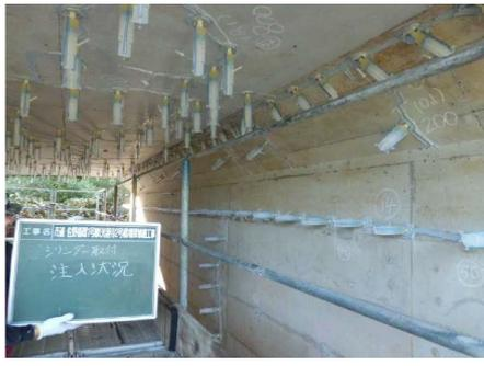
補修状況(ひびわれ補修工)
