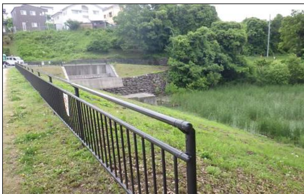
光吉谷川流量調整施設
