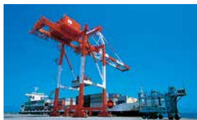
大分港大在コンテナターミナル
