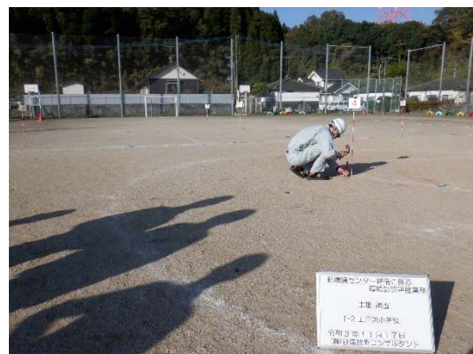
土壤調査状況
