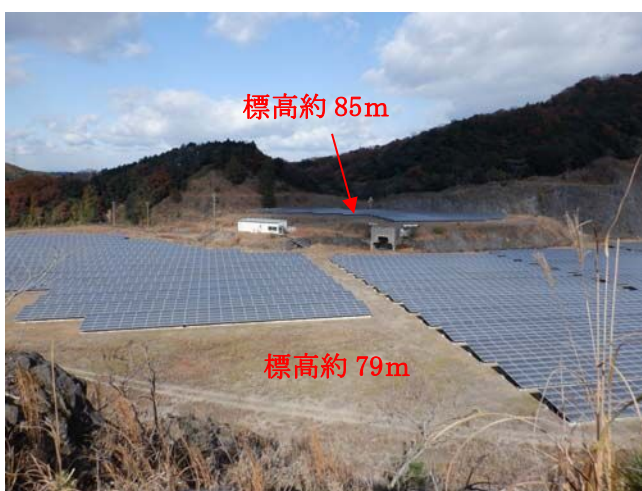
(南側から中央部を望む)
