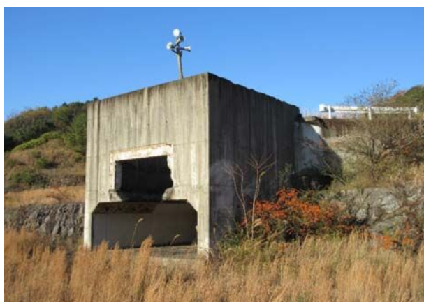
既存のコンクリート構造物
