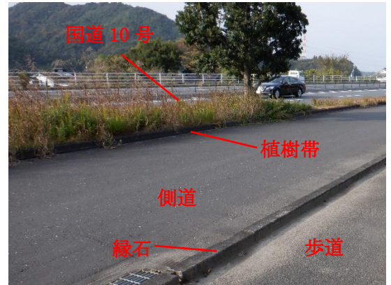
国道 10 号（対象事業実施区域付近）の状況
