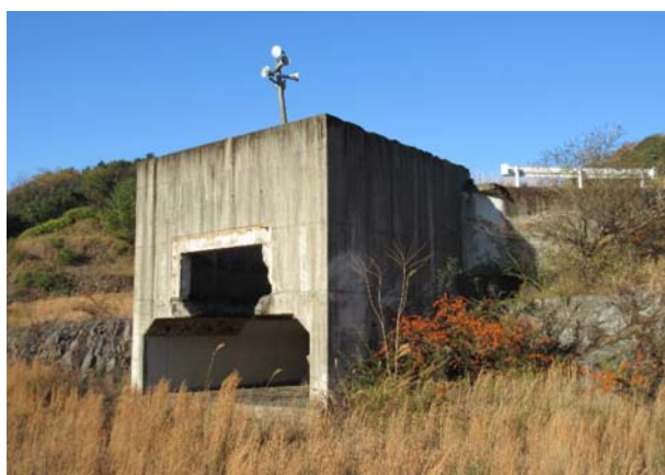
既存のコンクリート構造物
