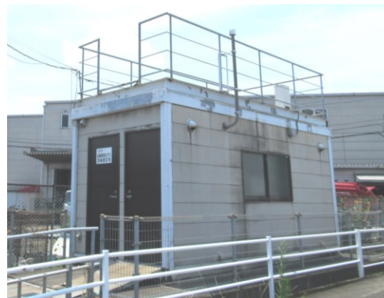
② 自動車排出ガス宮崎測定局
