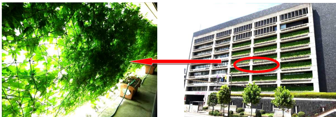
市役所本庁舎南側の緑のカーテン
