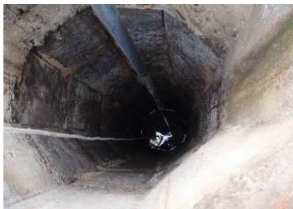
地下水質調査風景
