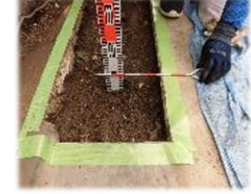
モルタル塗り作業
