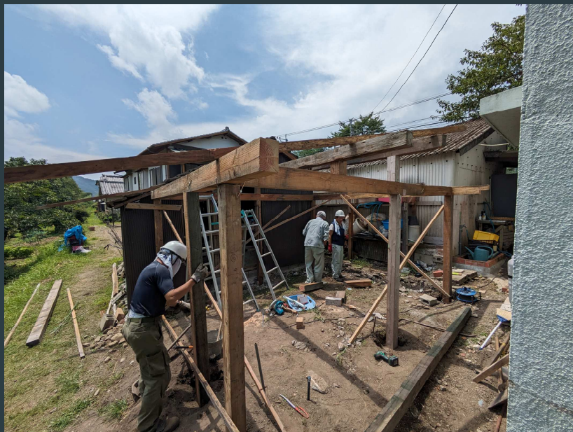
作業小屋増築
