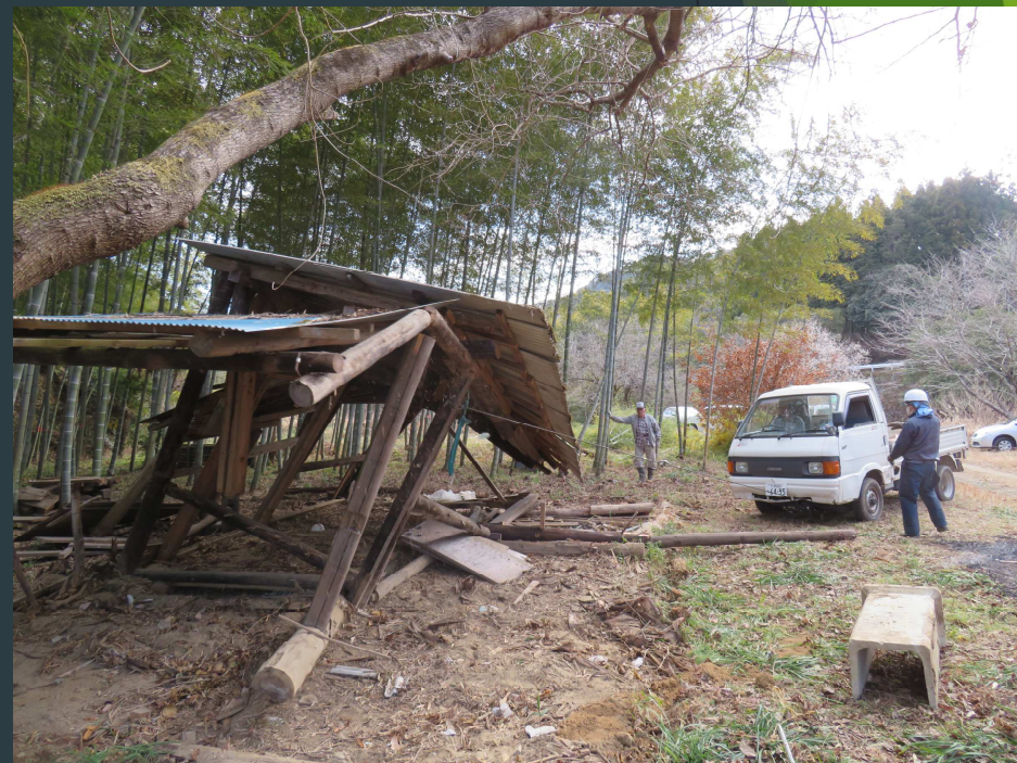
小屋解体作業（河原内）
