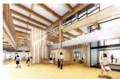
町産材桧による木造の松野町庁舎
