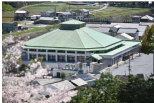
復旧した乙亥会館
