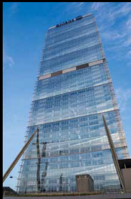
シティライフ・アリアンツ・タワー (2015) 2015ミラノ万博の際に建設され、現在は保険会社の持ちビルとなっている
