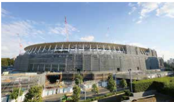
建設が進む新国立競技場
