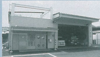
▲東消防署坂ノ市出張所
