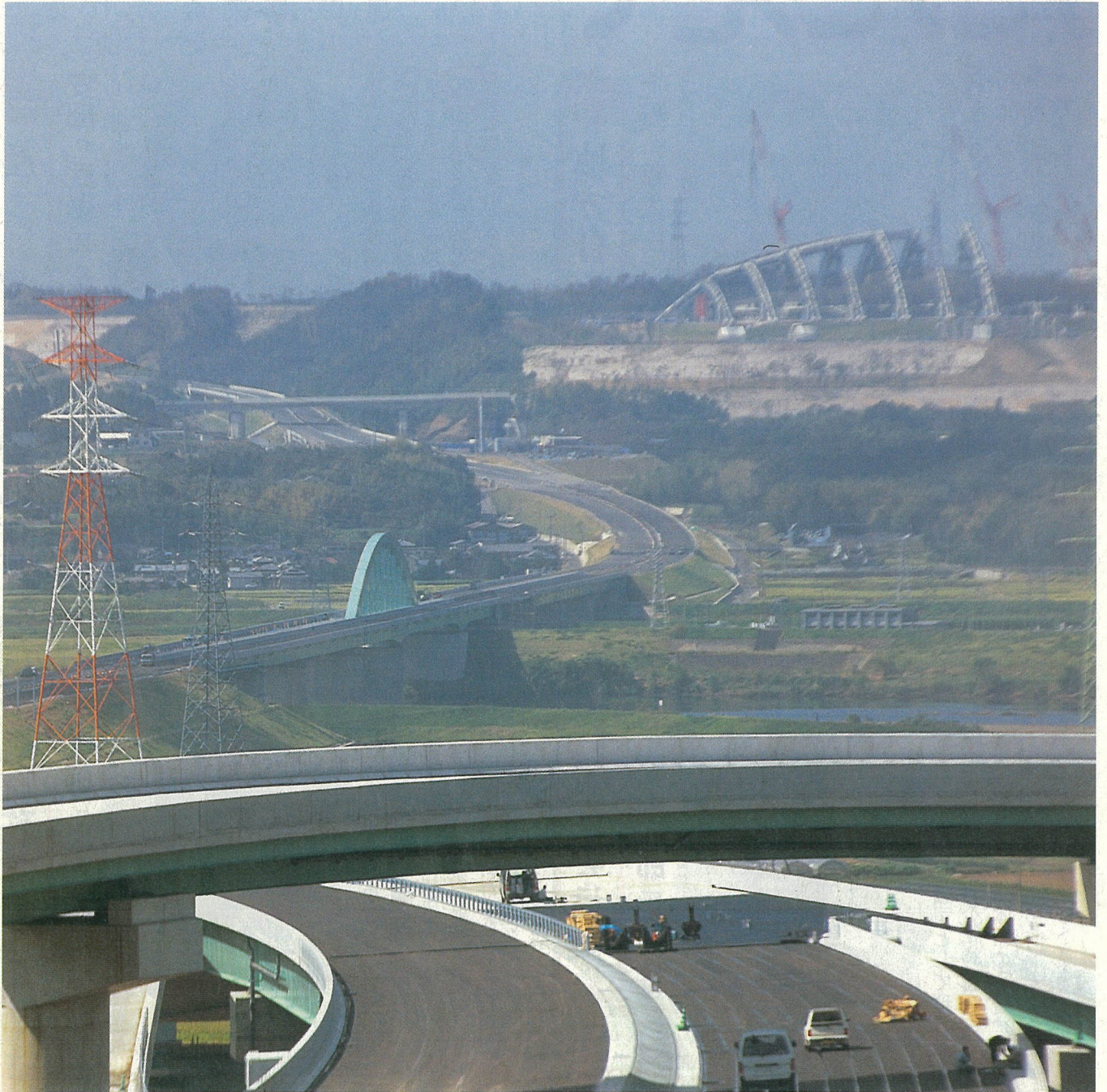
東九州自動車道 大分米良～大分宮河内間 11月27日開通
