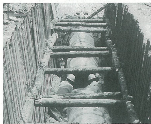
配水管布設工事
