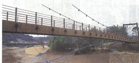
親水ゾーン〔あやとり橋（手前）と三日月橋〕
