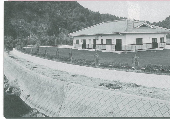
汚水処理施設
