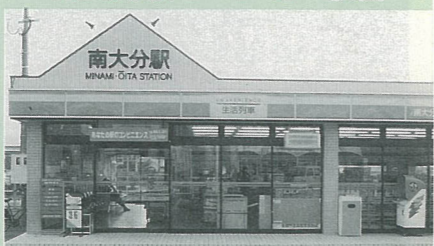
南大分駅のコンビニ駅舎
