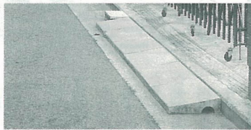
ブロックを置く (側溝の流れが悪くなる)
