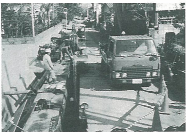
古くなった配水管の取替工事
