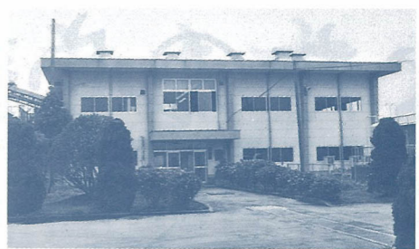
えのくま浄水場にある排水処理場
