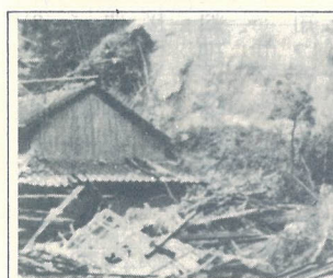
がけ地近接危険住宅移転事業で生命と財産を守りましょう
