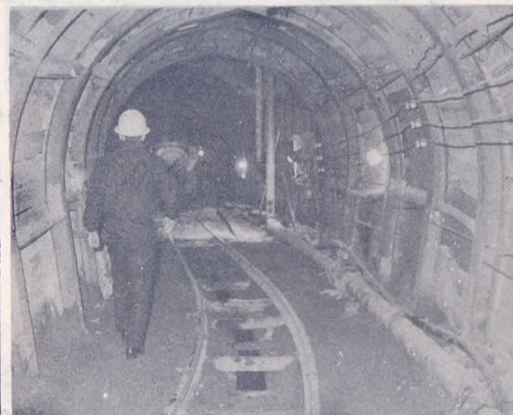
判田取水場着工
