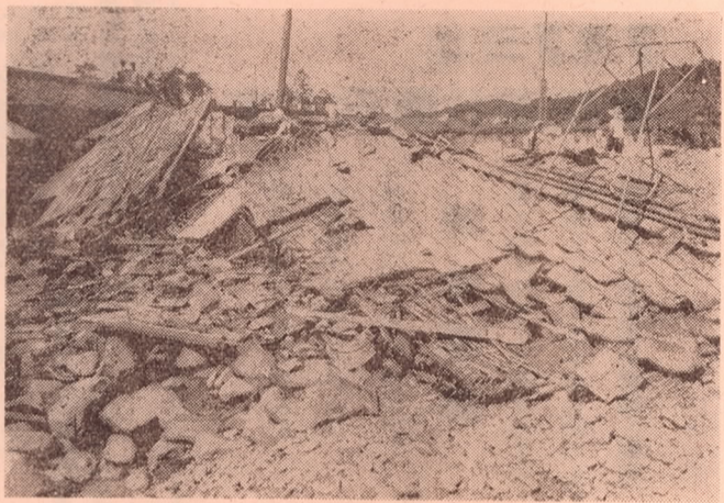
写真一 台風で破壊された家屋
