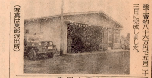
消防署 東部派出所 が完成
