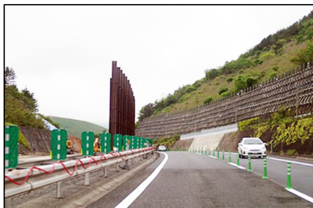
▽図表3 平成28年熊本地震の 由布岳PA付近復旧状況
