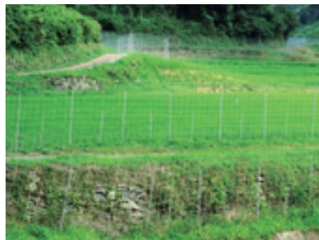
設置された防護柵
