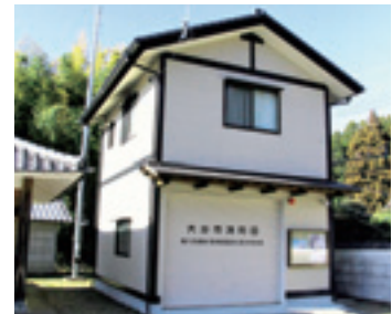
③消防団車庫詰所石合部
