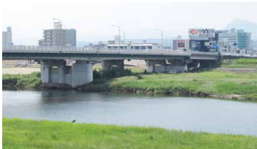
府内大橋 (河川調査地点)
