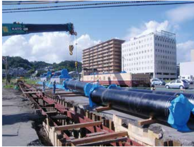
水道基幹管路耐震化
