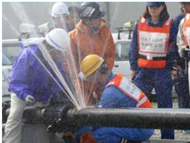
応急復旧訓練
