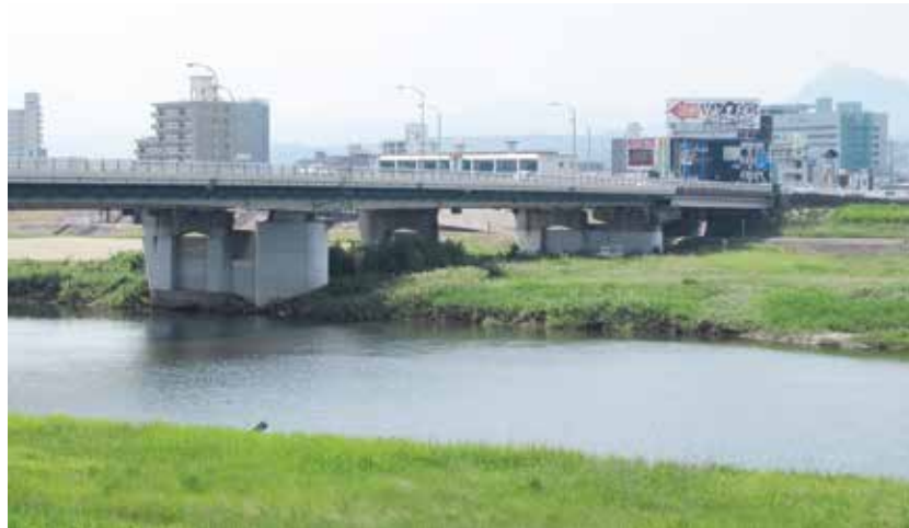
府内大橋 (河川調査地点)
