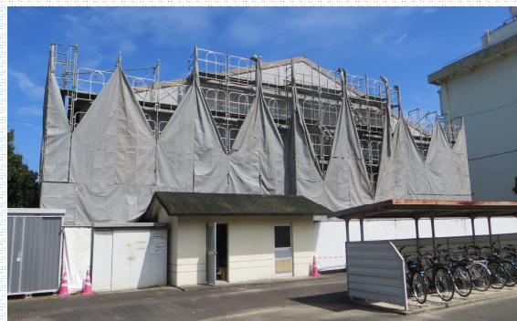
(大規模改修中の植田西中学校体育館)
